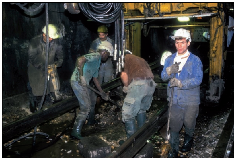
28 octobre 1999, Paris, RATP, réfection des voies la nuit sur la ligne 9.
