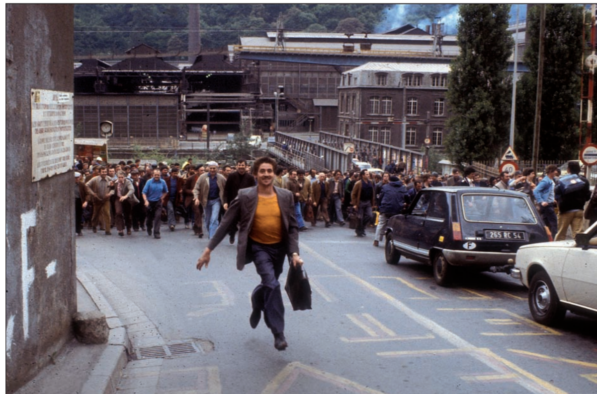
Sortie de l'usine Usinor, à Longwy, le 2 juillet 1979.
